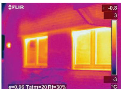
Da dove esattamente fuoriesce l'energia termica? La risposta ce la dà la termografia: le finestre vecchie (gialle) cedono molto calore.
